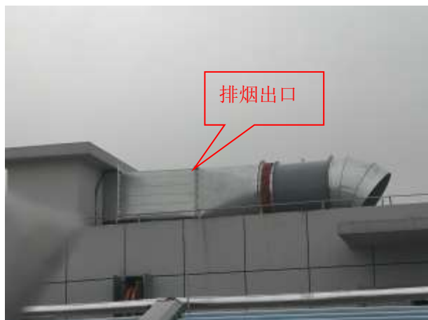
地下室排烟竖井
