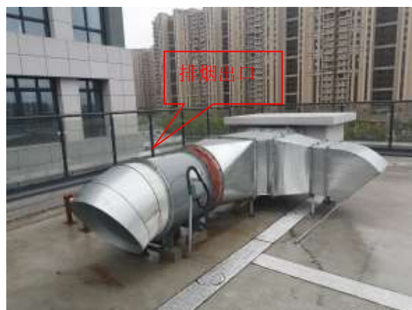
地下室排烟竖井
