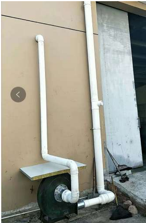
混料（压制）废气处理设施
