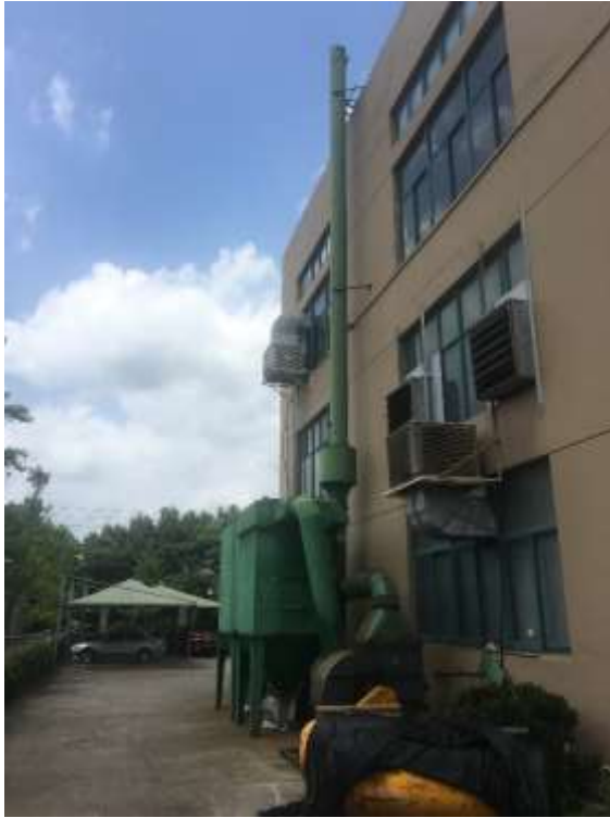
混料（压制）废气处理设施
