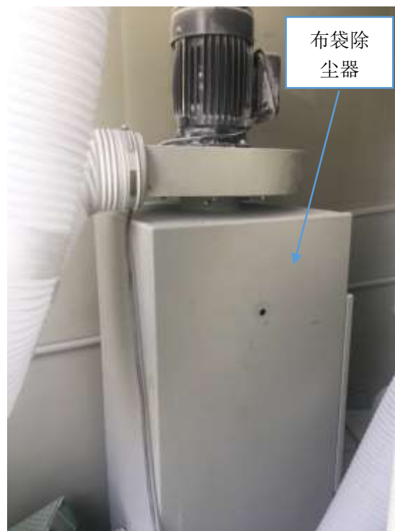
喷砂废气处理设施
