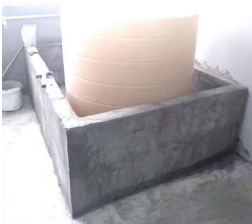
废退涂液围堰
