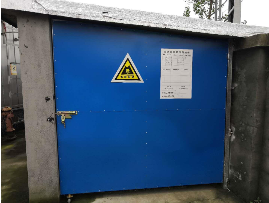
附件 5 固废暂存场所
