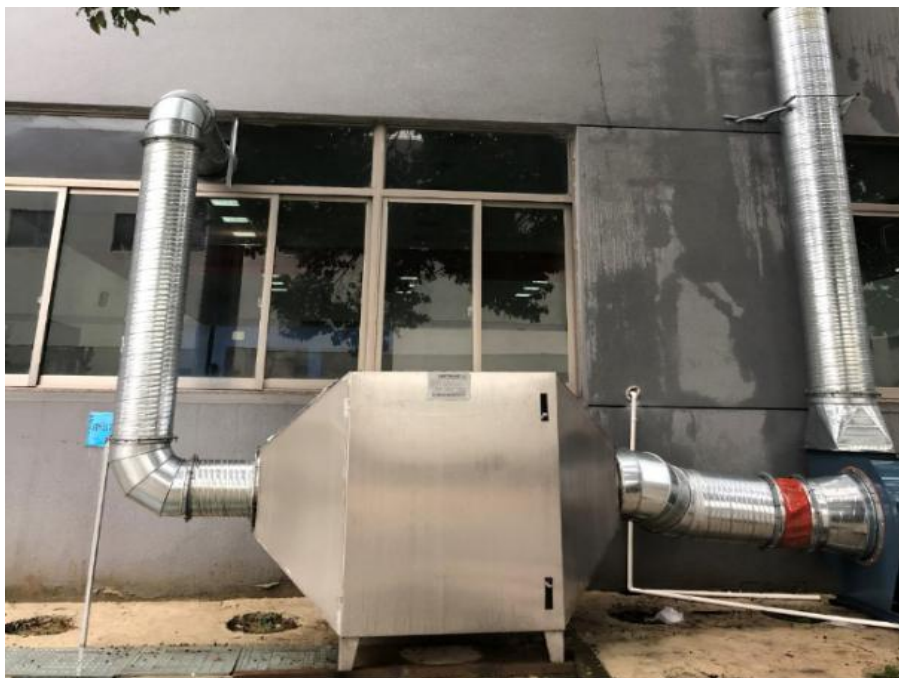
图 3-4 注塑废气处理设施图
