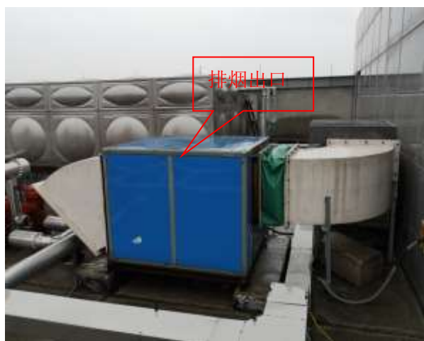
地下室排烟竖井
