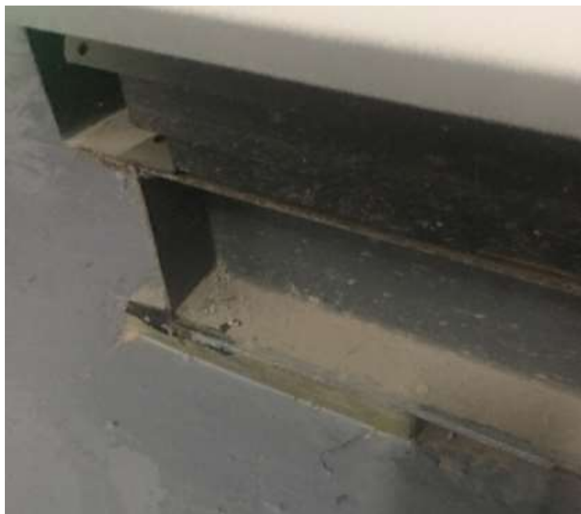
废气风机挠性连接
