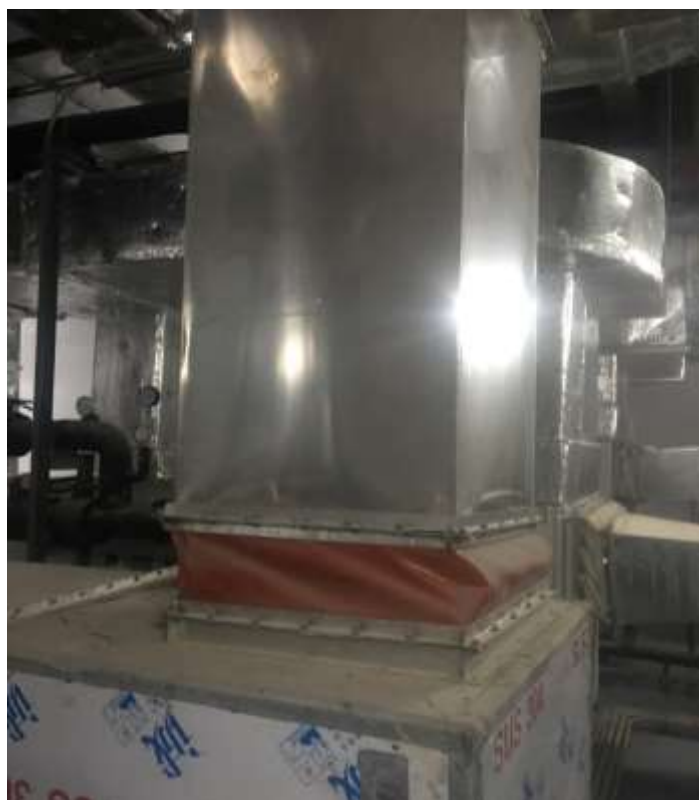
废气风机挠性连接
