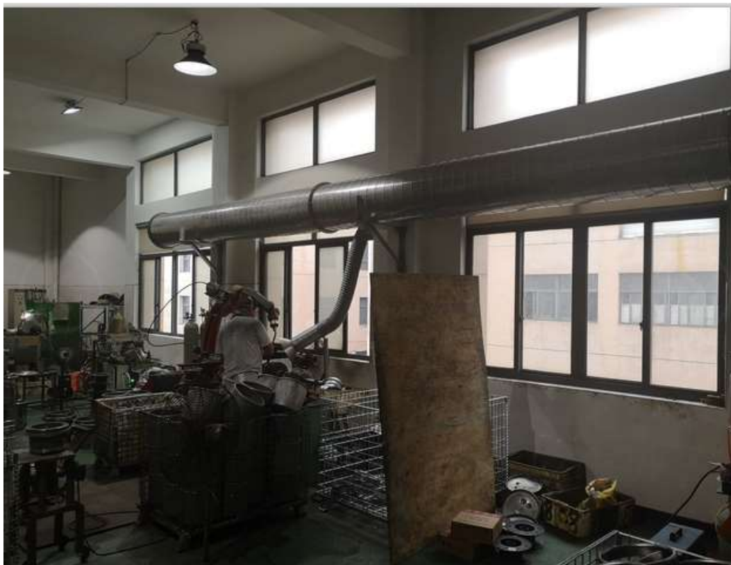
焊接废气管道
