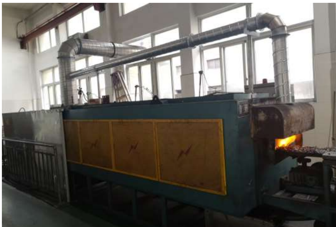
淬火、渗碳渗氮废气处理设施
