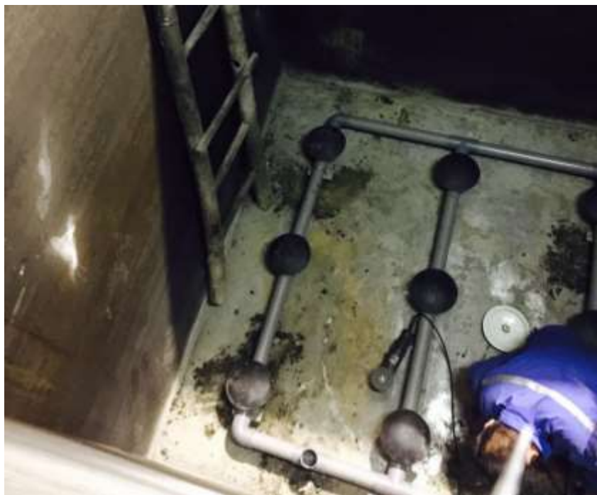
生产废水生化处理设施
